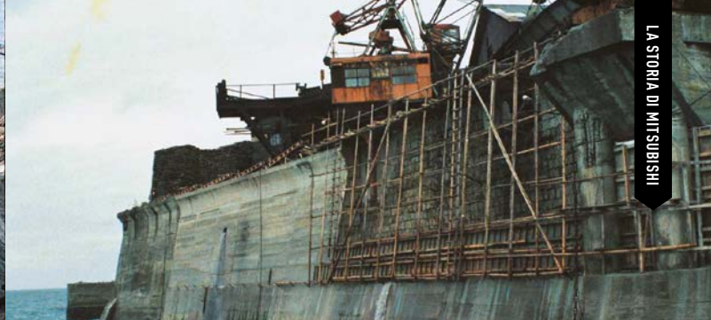
Una diga marittima che fa parte del Patrimonio dell'umanità. Ora in fase di restauro, è possibile vedere la muratura in pietra con l'argilla rossa e la calce usate come collanti (metodo Amakawa).
